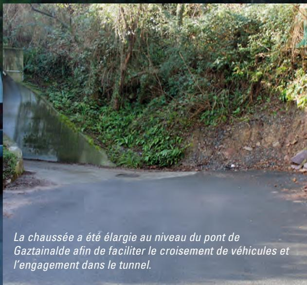
*La chaussée a été élargie au niveau du pont de Gaztainalde afin de faciliter le croisement de véhicules et l'engagement dans le tunnel.*
