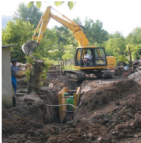
Travaux à Aguerria
