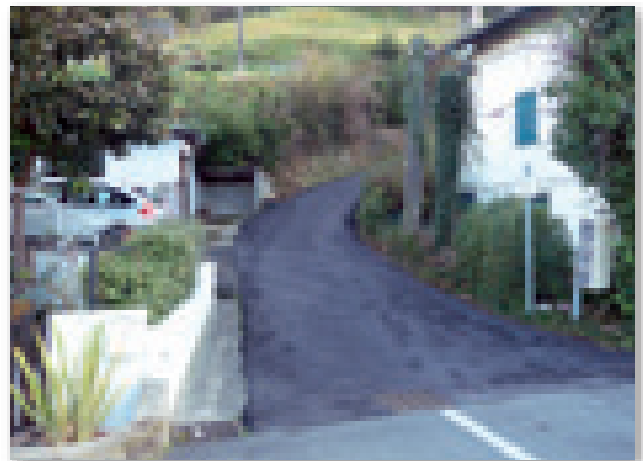
Enrobés à chaud au Chemin de Hézou Hézou bidearen arraberritzea
